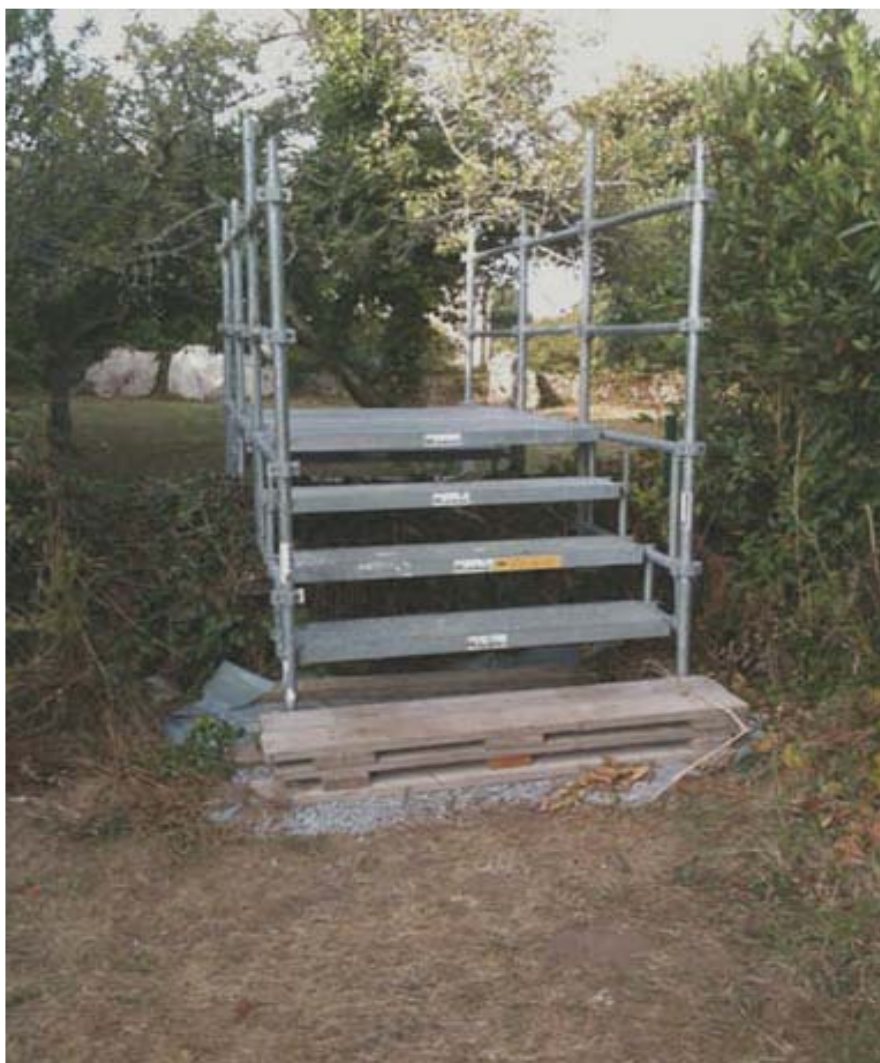
Passerelle Aluminium mise en place sur consigne su SRA
